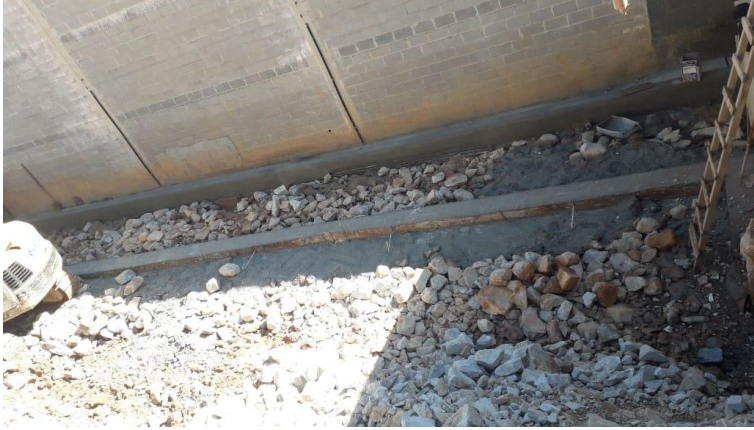
Concretagem da soleira
