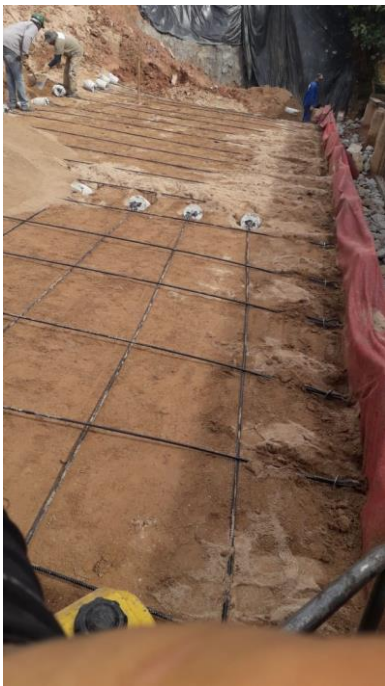
Instalação dos tirantes e “slump” de ancoragem
