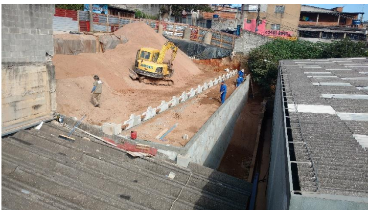
Finalização do muro 1 e início do muro 2 com a instalação da fiada 1
