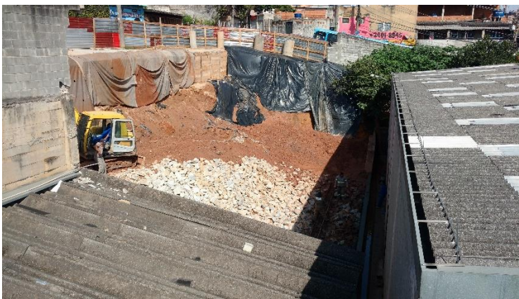
Colocando rachão para dreno de fundo e início da forma da soleira para o muro Batcon
