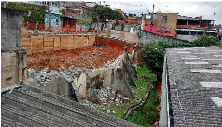
Demolição do muro de contenção que rompeu
