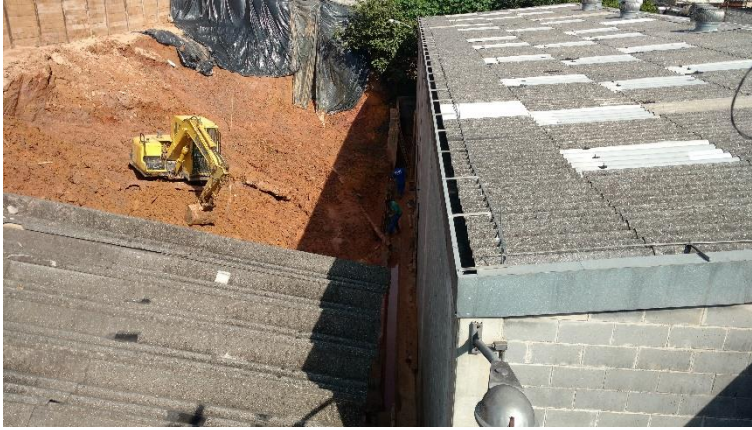
Remoção de solo e início da mureta da drenagem de fundo
