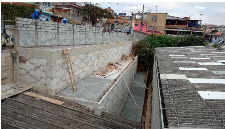
Topo dos muros 1 e 2 concretados e construção do muro de divisa
