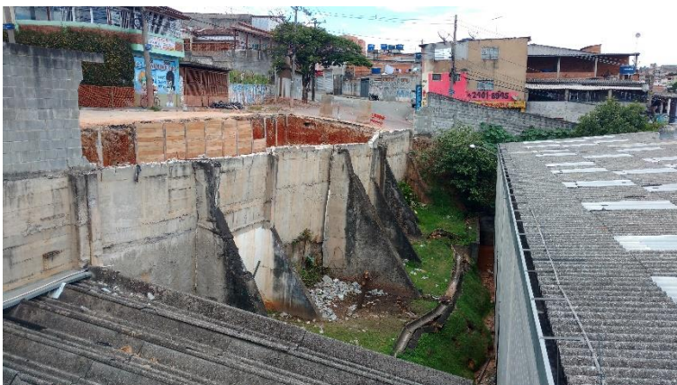
Escoramento do talude no meio da rua devido a adutora de alta pressão na calçada do lado oposto
