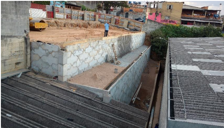
Finalização do muro 2 com forma da viga de acabamento
