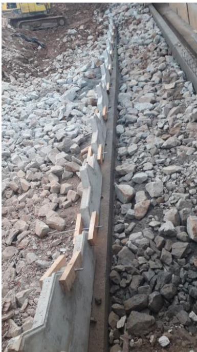
Instalação da primeira fiada de placas na soleira
