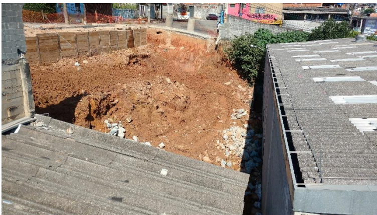
Finalização da demolição do muro e remoção do solo
