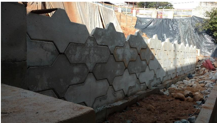
Montagem do muro
