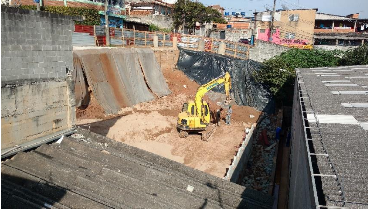
Montagem do muro
